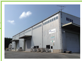
▲日本ビルテクノス 工場検査部門
